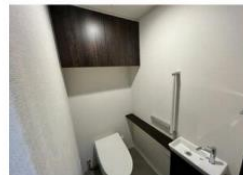
温水洗浄便座付きのトイレです。手洗いのしやすい、独立型手洗い器が設置されています。
